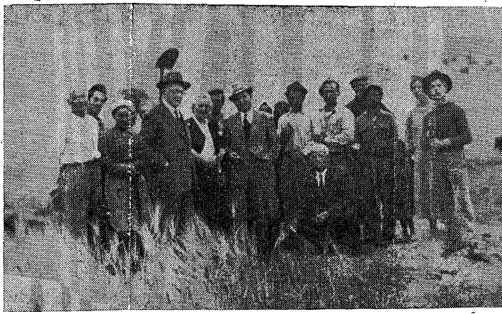
Ὁ Νομάρχης Φωκίδος κ. Ἀρκέντης (εἰς τὸ μέσον μετὰ τὸ καπέλλο ἐπὶ κεφαλῇ) μετὰ τῶν ἐργατῶν εἰς τὸ διανοιχθὲν τμήμα τῆς ὁδοῦ Γαλαξειδίου—Ἰτέας.
